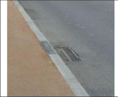
Sur du bitume
